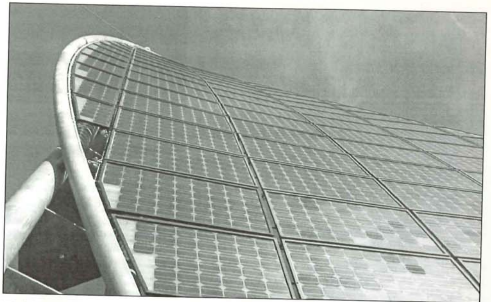
Die bläulich schimmernden Siliziumzellen verleihen dem Objekt eine Farbe, die sich je nach Sonnenstand immer wieder verändert.
